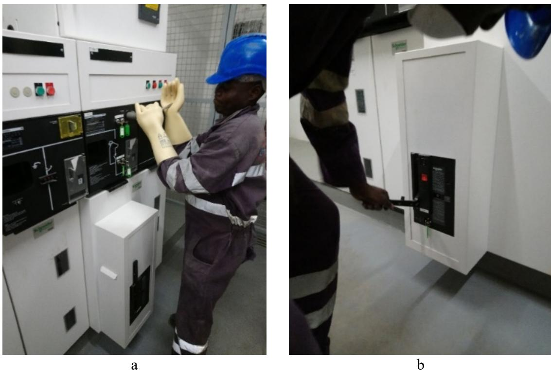
Рис. 14. Возврат ТП в рабочее состояние
