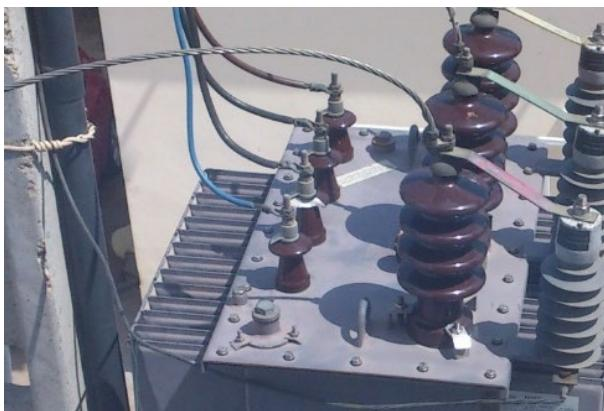
Рис. 1. Трансформатор с сломанным изолятором
