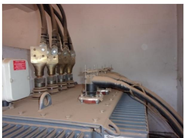
Рис. 4. Грязь в корпусе
