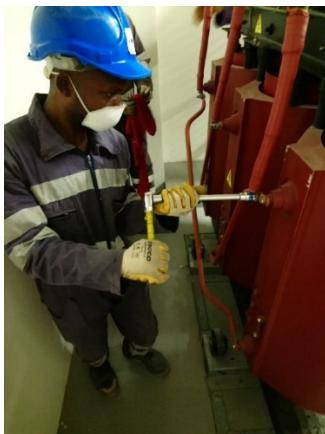
Рис. 9. Затягивание болтов в трансформаторе
