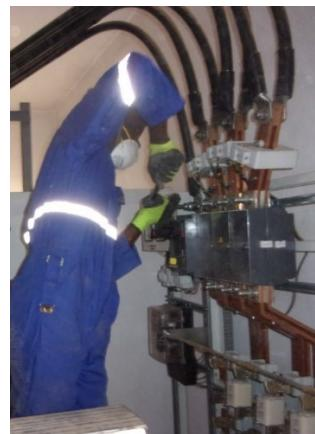
Рис.10. Затягивание гаек в РУ НН
