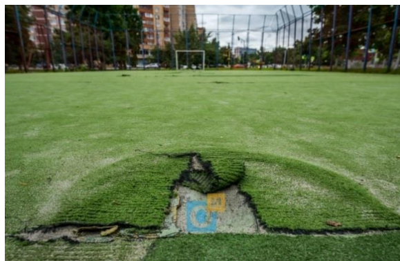
Рис. 6. Деформации ударопоглощающего покрытия
