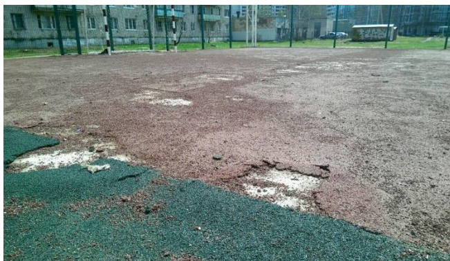
Рис. 6. Деформации ударопоглощающего покрытия
