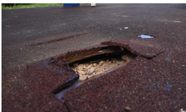
Рис. 8. Наплывы бетона при устройстве основания под покрытие с частичками мусора
