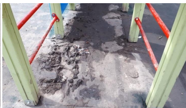
Рис. 8. Наплывы бетона при устройстве основания под покрытие с частичками мусора
