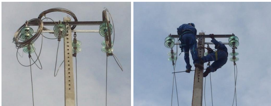
Рис. 3. Готовая опора ЛЭП.
