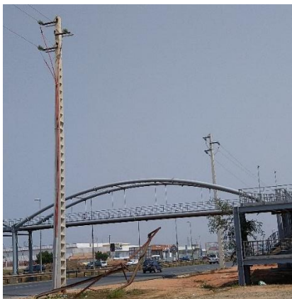
Рис. 5. Переход ЛЭП в сетях СН
