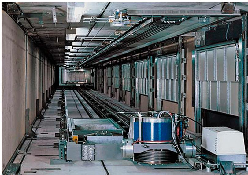
Рис. 5. Электропривод лифтового оборудования
