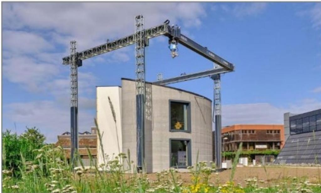
Рис. 6. 3D-принтер portalного типа
