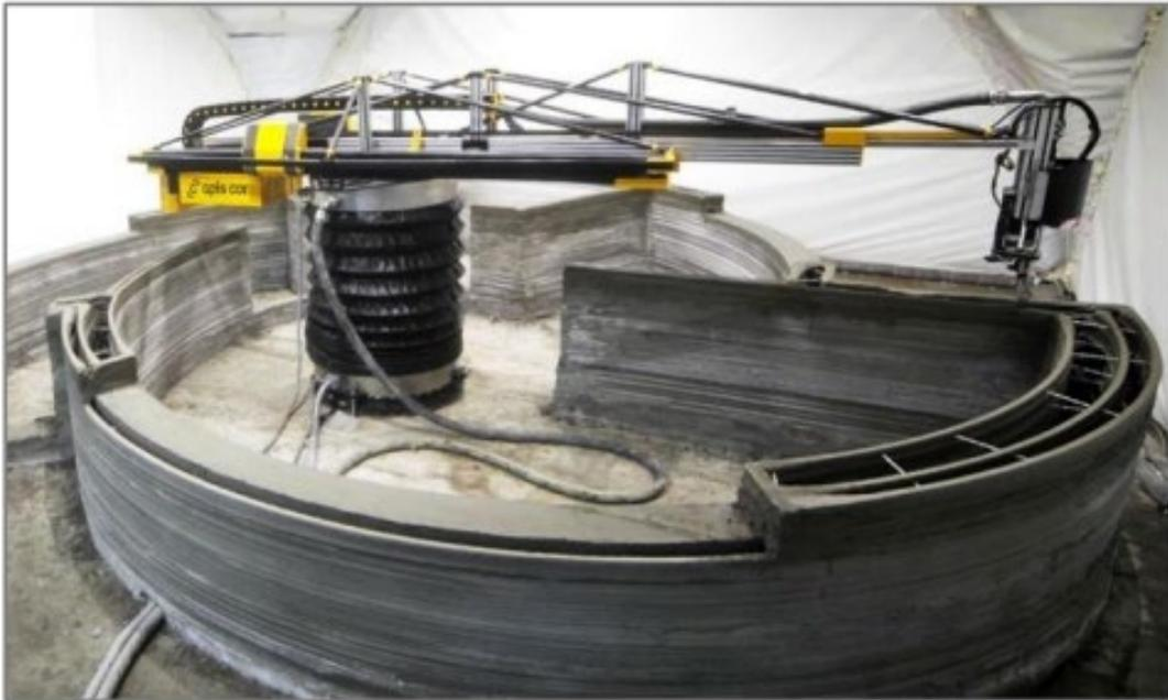
Рис. 5. 3D-принтер с роботизированной рукой
