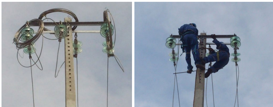
Рис. 3. Готовая опора ЛЭП.
