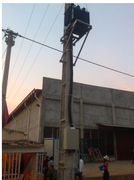
Рис. 4. ТП столбового типа
