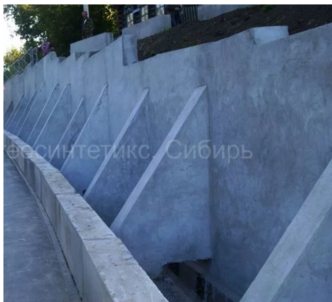
Рис. 4. Контрфорсная подпорная стенка
