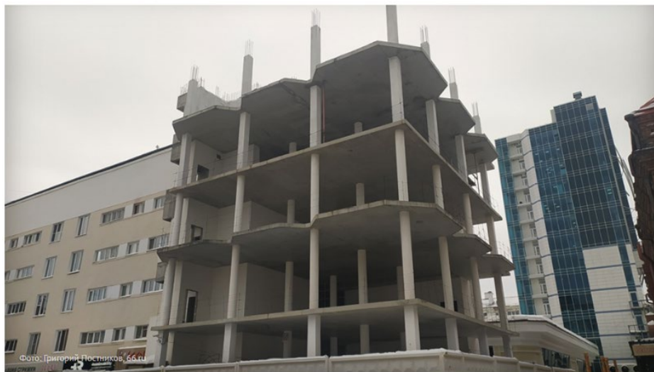
Рис. 1. Фотография каркаса недостроенного объекта. Автор фотографии: Г. Постников; Источник: https://66.ru/realty/news/237917/
