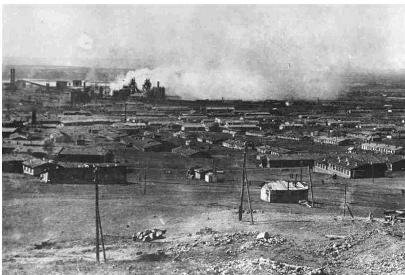
Рис. 3. Строительство г. Магнитогорска лето 1930 года
