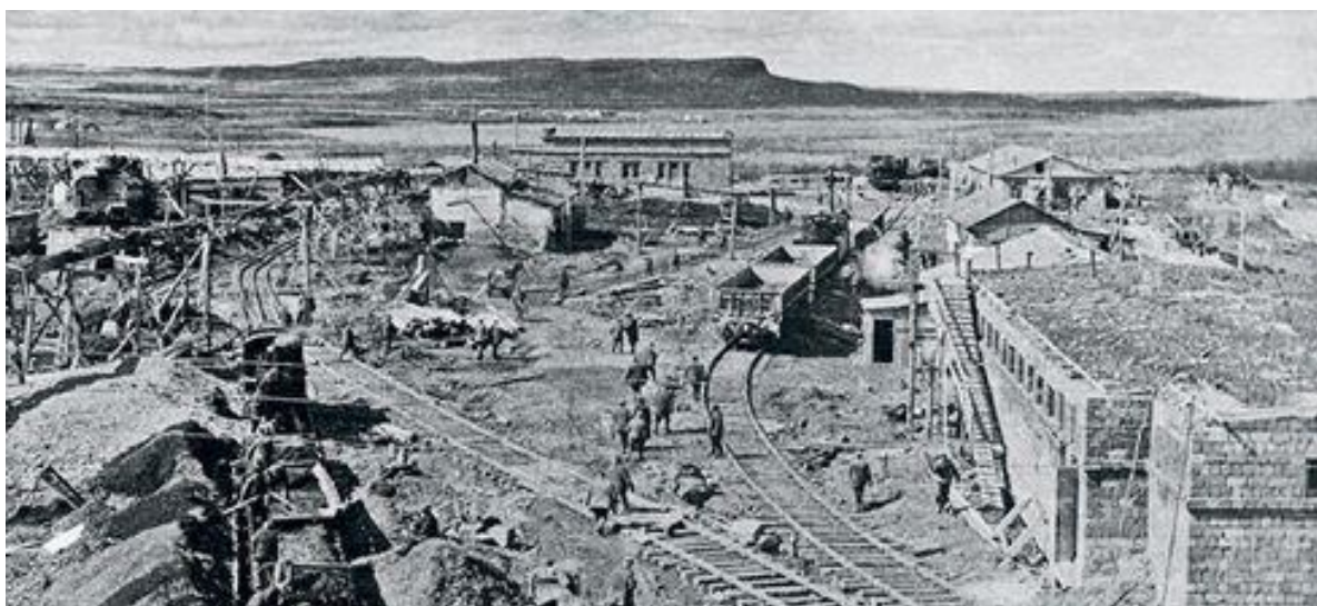
Рис. 1. Строительство Норильска 30-ые годы прошлого века
