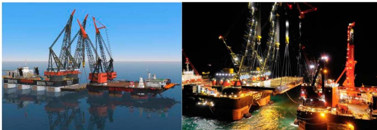
Рис. 3. Цифровой двойник Quad Lift (подъемника с четырьмя кранами) производства «Thialf and Balder» (слева) и Quad Lift на шельфе (справа) [8, 9]
