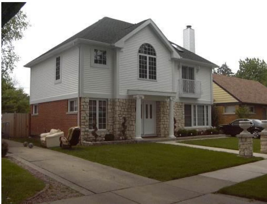
Рис. 1. Быстровозводимый коттедж из системы «Мобильный город»
