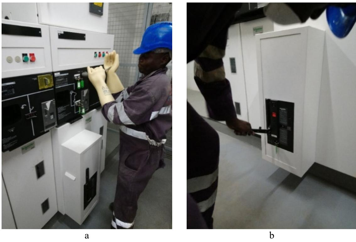
Рис. 14. Возврат ТП в рабочее состояние
