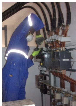
Рис.10. Затягивание гаек в РУ НН
