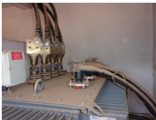
Рис. 4. Грязь в корпусе
