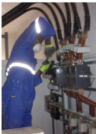
Рис.10. Затягивание гаек в РУ НН
