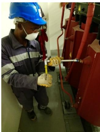
Рис. 9. Затягивание болтов в трансформаторе
