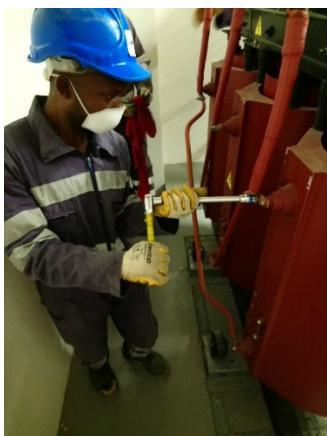
Рис. 9. Затягивание болтов в трансформаторе
