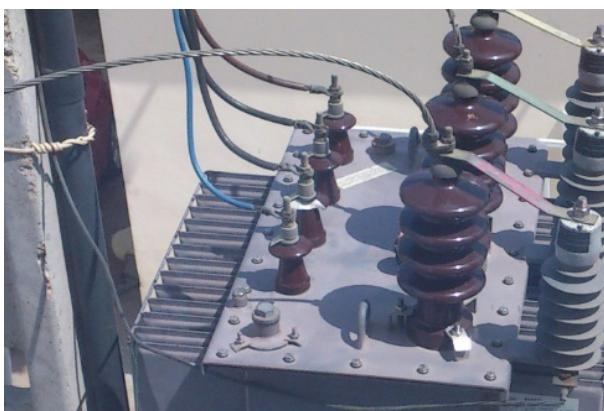
Рис. 1. Трансформатор с сломанным изолятором
