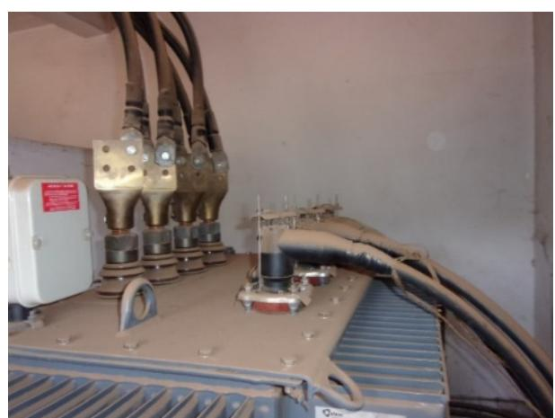
Рис. 4. Грязь в корпусе
