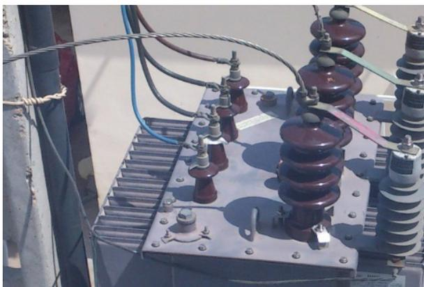
Рис. 1. Трансформатор с сломанным изолятором
