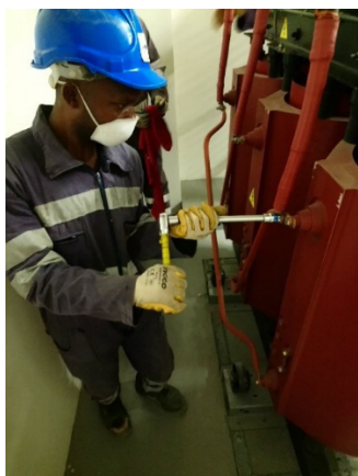
Рис. 9. Затягивание болтов в трансформаторе
