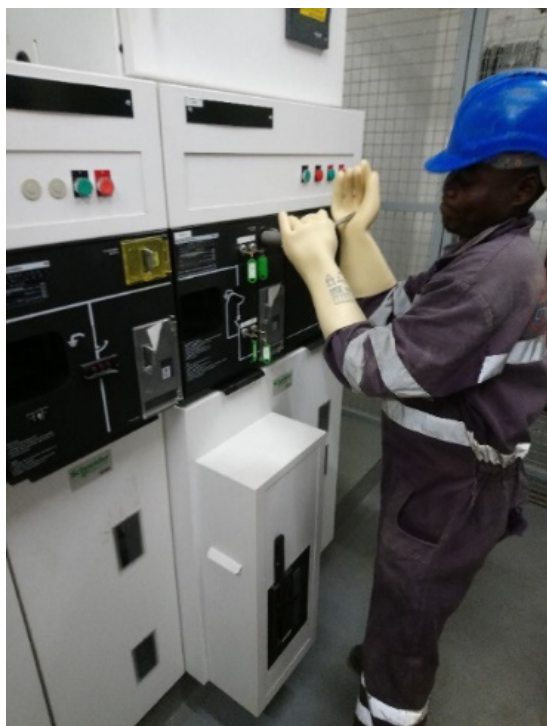
Рис. 14. Возврат ТП в рабочее состояние
