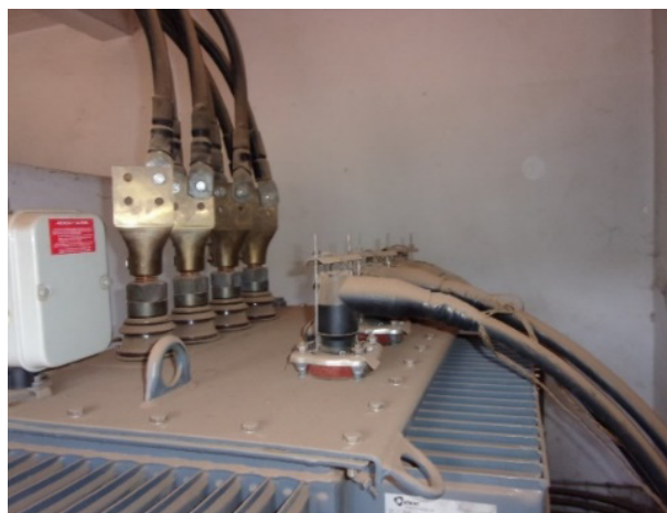
Рис. 4. Грязь в корпусе
