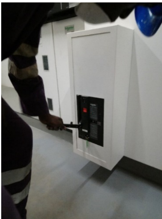
Рис. 14. Возврат ТП в рабочее состояние
