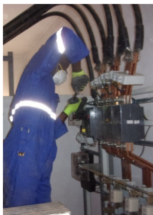
Рис.10. Затягивание гаек в РУ НН
