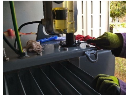
Рис. 11. Затягивание гаек в термометре трансформатора
