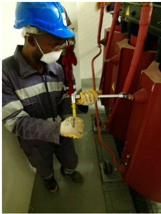
Рис. 9. Затягивание болтов в трансформаторе
