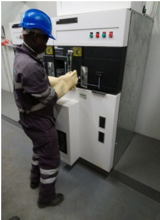
Рис. 6. Отключение ТП
