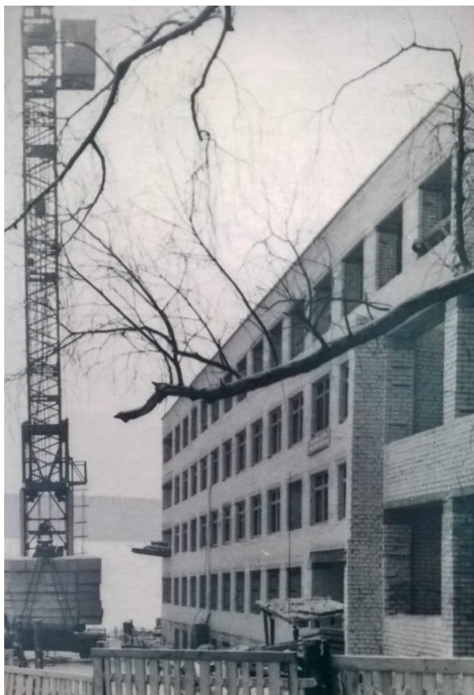
Рис. 4. Реконструкция здания и новый корпус водной больницы
