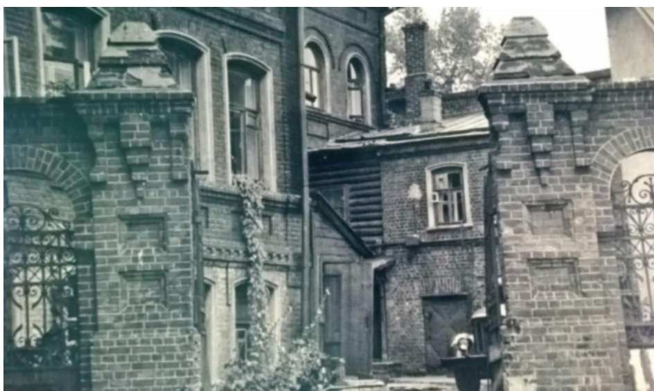
Рис. 1. Здание больницы Верхне-волжского речного пароходства
