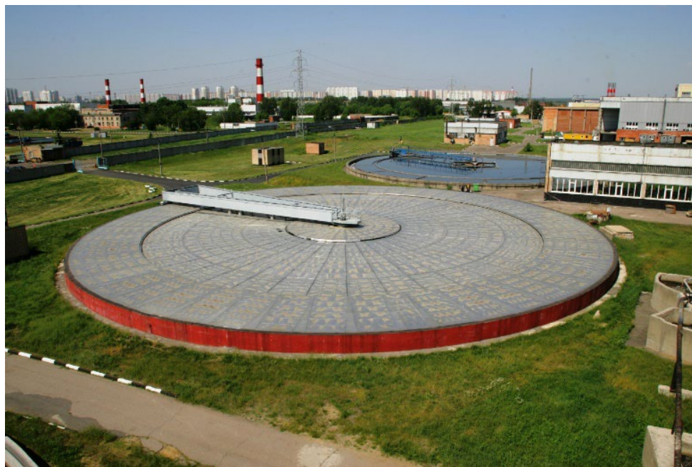
Рис. Перекрытый первичный отстойник ЛОС [6]
