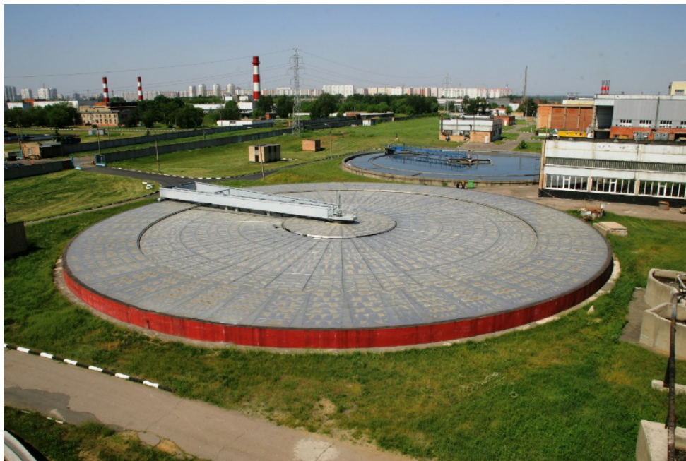
Рис. Перекрытый первичный отстойник ЛОС [6]
