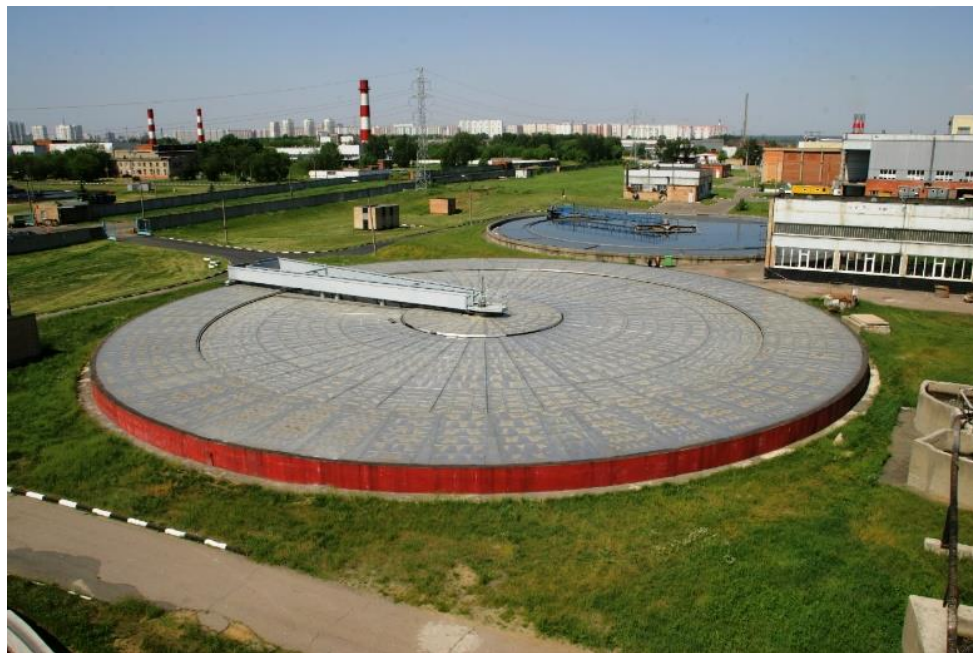
Рис. Перекрытый первичный отстойник ЛОС [6]
