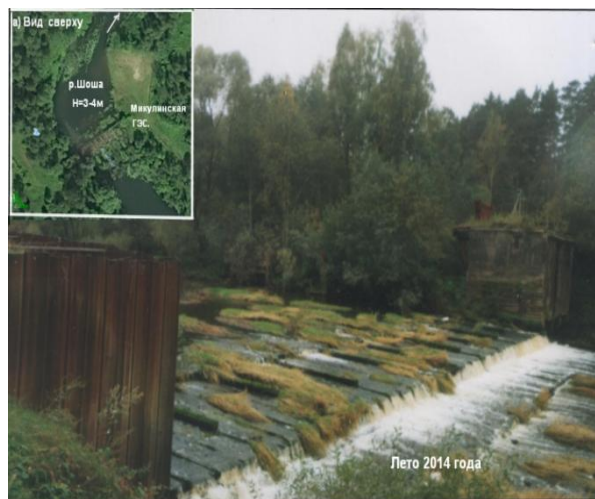
Рис. 12. Старая разрушенная плотина Микулинской ГЭС на реке Шоша. Лето 2014года. Фото-вставка: рис.12а. Вид плотины сверху из космоса. Тот же период времени
