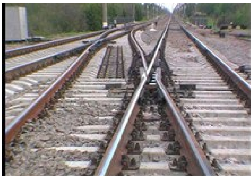
Рис. 2. Съезд типа Р65 марки 1/11 на железобетонных брусках для скоростного движения (до 200 км/ч), проект № 2728
