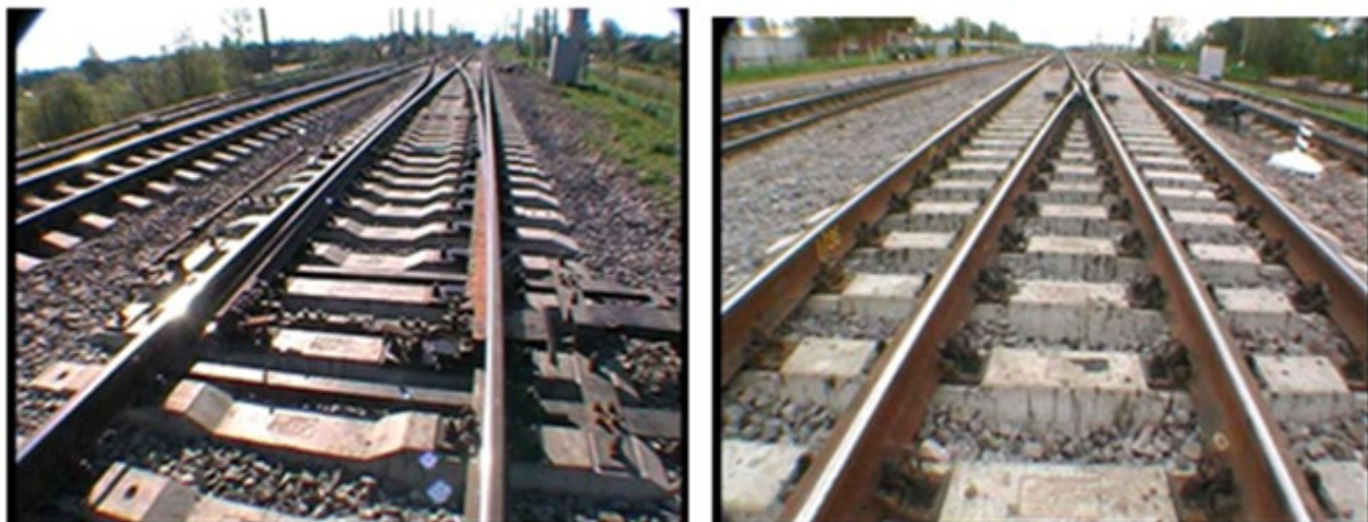
Рис. 1. Стрелочный перевод типа Р65 марки 1/11 на железобетонных брусках для скоростного движения (до 200 км/ч), проект № 2726
