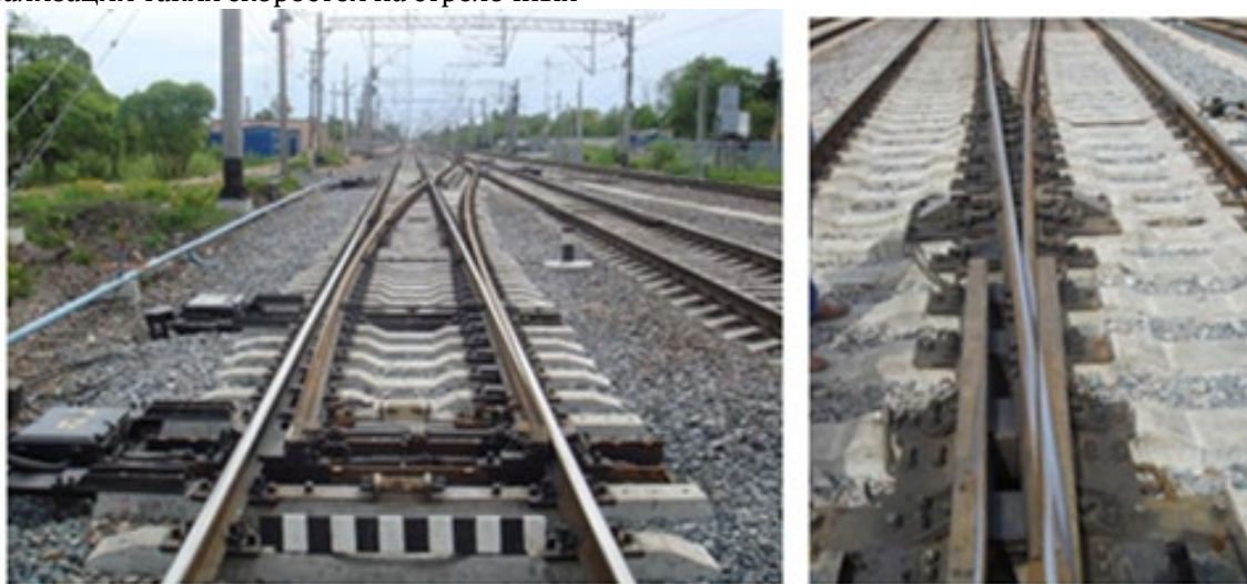
Рис. 4. Стрелочный перевод типа Р65 марки 1/11 для высокоскоростного движения пассажирских поездов со скоростями до 250 км/ч по прямому пути, проект № 2956 (гибко-поворотный сердечник)
