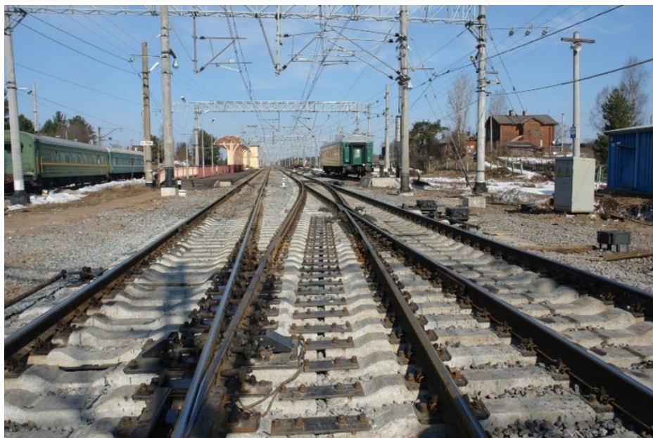
Рис. 5. Съезд типа Р65 марки 1/11 с междупутьем 4232 мм для высокоскоростного движения пассажирских поездов со скоростями до 250 км/ч по прямому пути, проект № 2968
