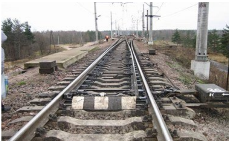
Рис. 3. Стрелочный перевод типа Р65 марки 1/18 с непрерывной поверхностью катания на железобетонных брусках со скоростями движения до 200 км/ч, проект № 2870
