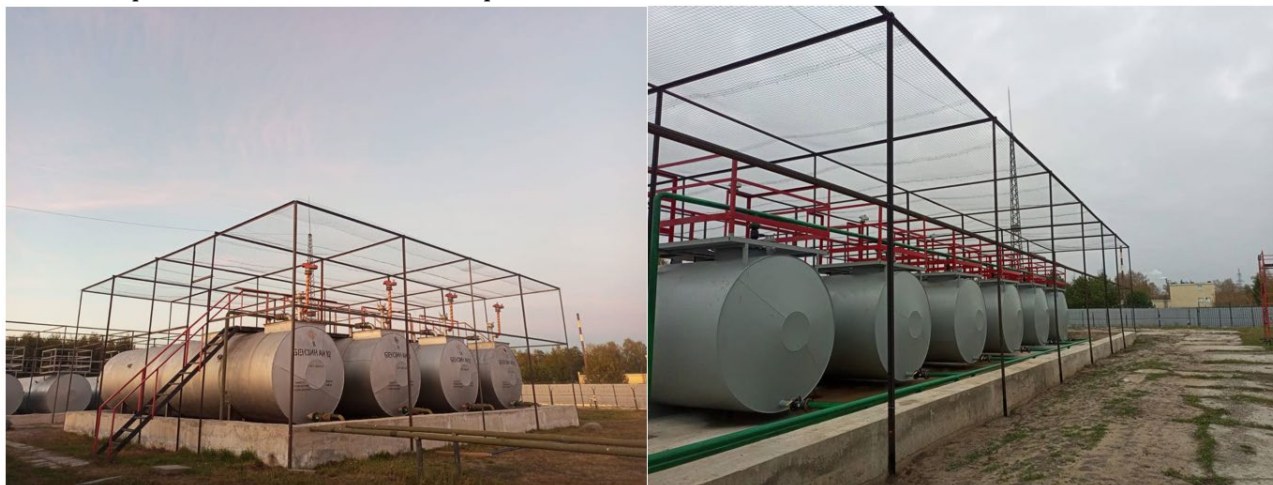
Рис. 2. Вариант установки антидроновых сеток на объекте
