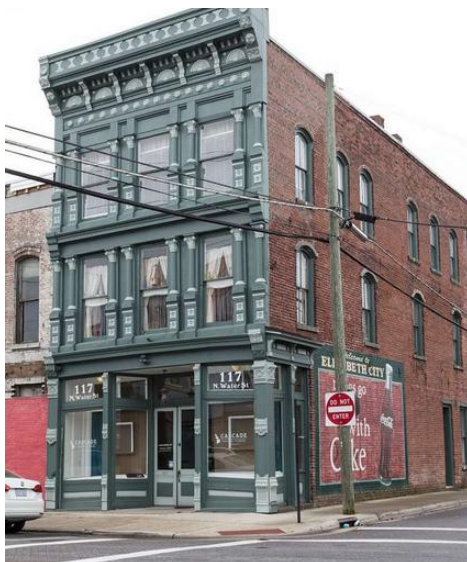
Рис. 4. Историческая реклама Coca-Cola на боковом фасаде здания в штате Северная Каролина
