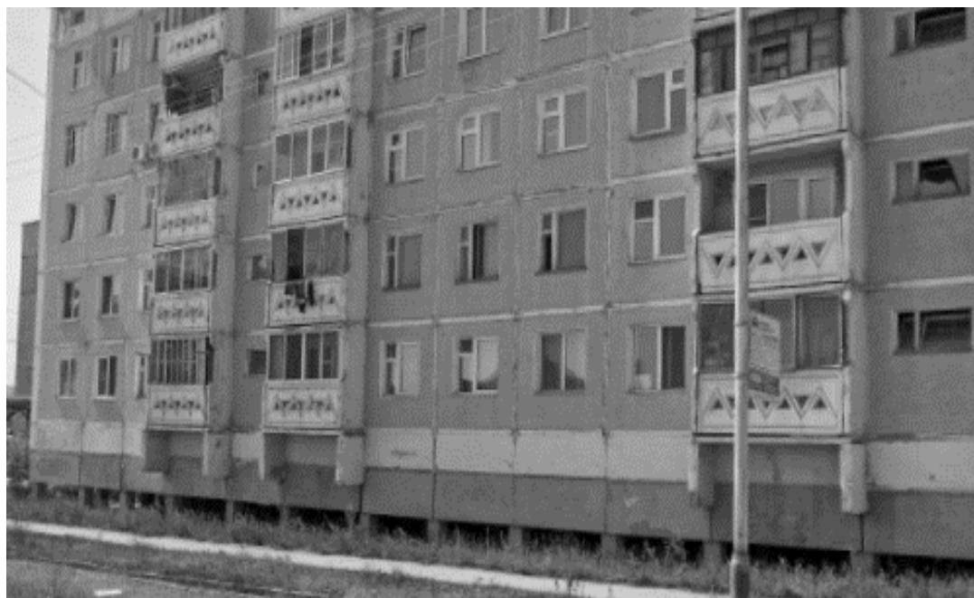
Рис. 4. Жилой дом на намывных грунтах с вентилируемым подпольем
