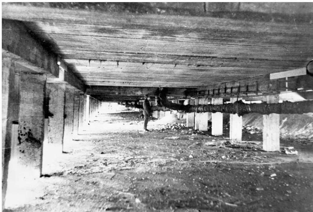
Рис. 1. Проветриваемое подполье в жилом доме
