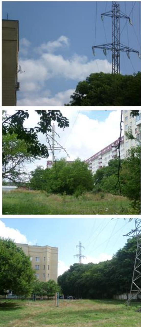
Рис. 1. Фотографии расположения линии электропередачи 110кВ и жилых домов
