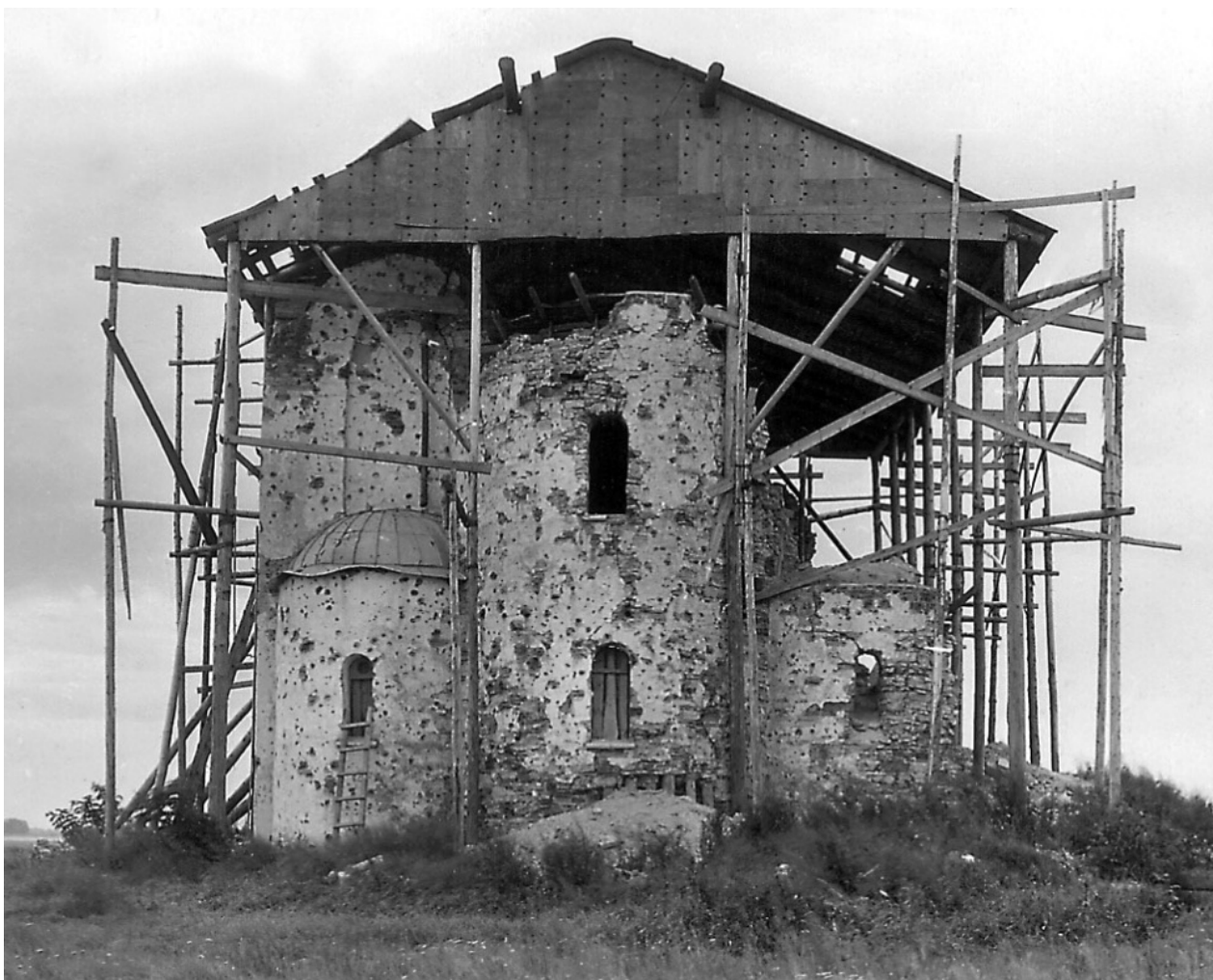
Рис. 15. Руины церкви Спаса на Нередице, укрепленные лесами и защищенные металлическим навесом
