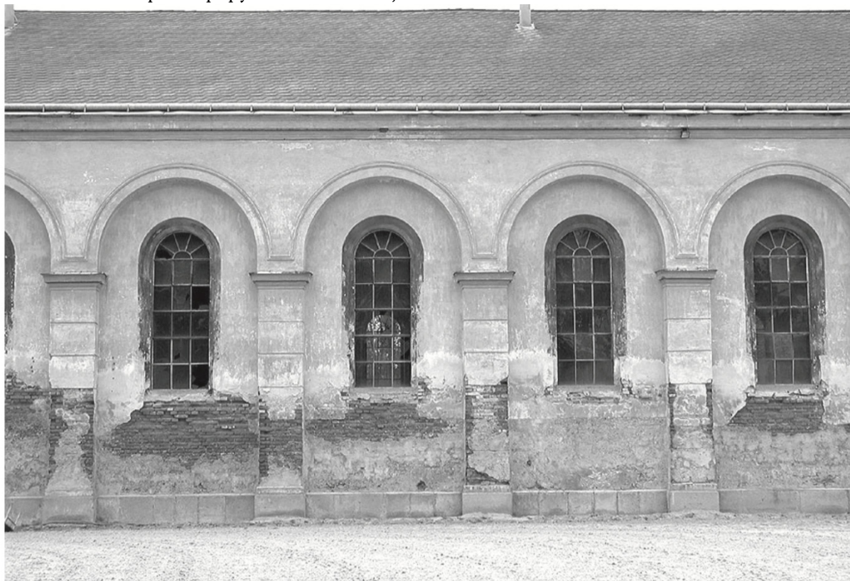
Рис. 21. Пример неправильного выбора реставрационного материала на цементном вяжущем [10]
