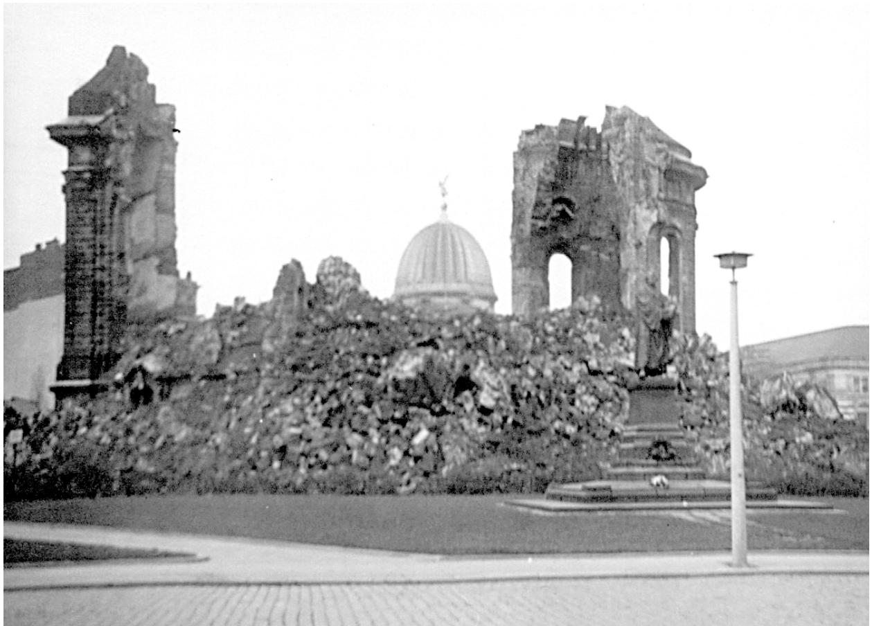
Рис. 17. Руины церкви Фрауэнкирхе в Дрездене
