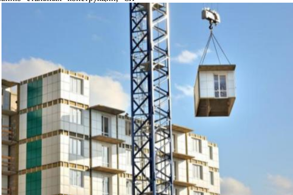
Рис. Монтаж железобетонного модуля типа «колпак» [3, с. 26-33]
