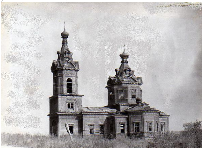
Рис. 2. Деревянная церковь Параскевы-Пятницы в селе Казывань, 1767
