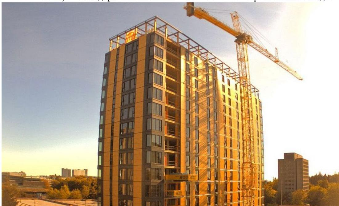
Рис. 3. 18-этажное студенческое общежитие Brock Commons в Ванкувере было возведено из CLT за всего 70 дней, тогда как постройка аналогичных зданий традиционными методами занимает более полугода [6]
