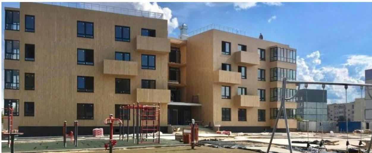
*Рис. 5. 4-этажные дома из CLT-панелей в г. Сокол*
