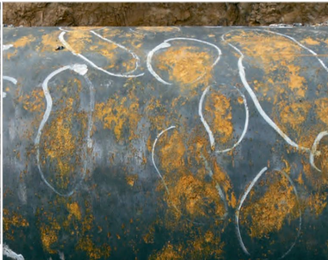
Рис. 1. Пример выявления повреждения изоляции и коррозии на участке трубопровода с помощью БПЛА с камерой высокого разрешения
