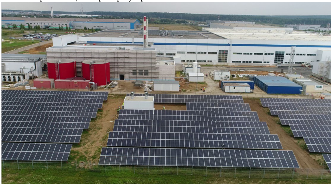
Рис. 1. Фотоэлектрические панели на территории завода компании L'Oréal в Калуге. Вырабатывают около 10% годового энергопотребления завода [5]
