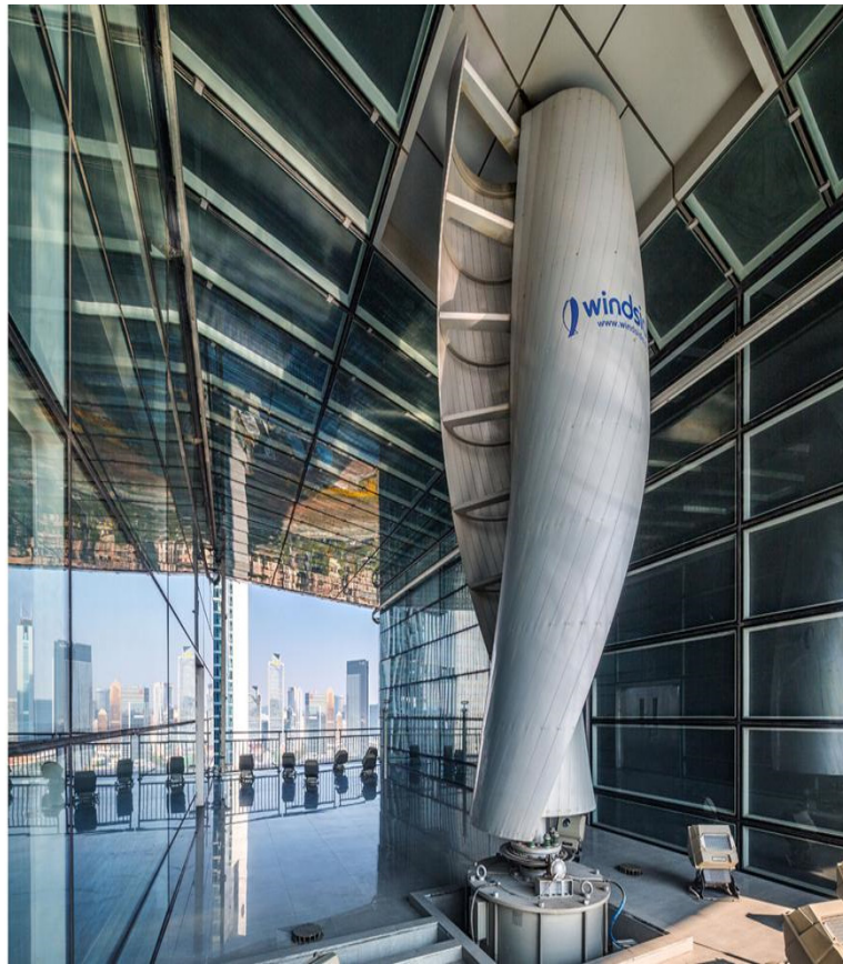
Рис. 5. Фасад здания дополнен двумя обтекаемой формы нишами, где расположены ВЭУ вертикального типа
