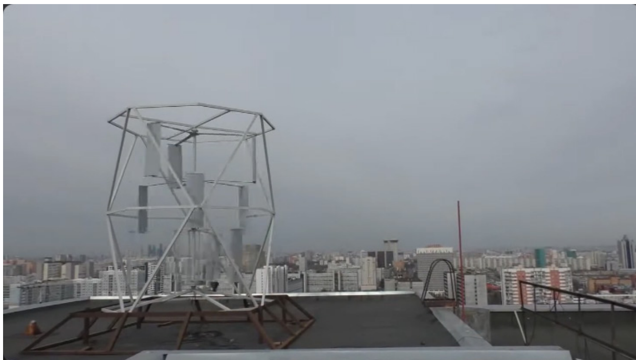
Рис. 8. Роторный ветрогенератор, расположенный на крыше 16-этажного здания в Москве
