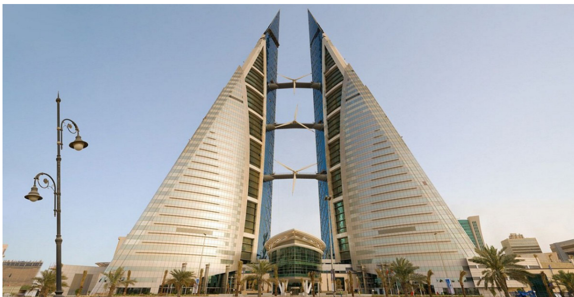
Рис. 7. Здание торгового центра Bahrain World Trade Center, построенное в бахрейнском городе Манама. Интегрированные в конструкцию ветрогенераторы обеспечивают 15% энергопотребления здания
