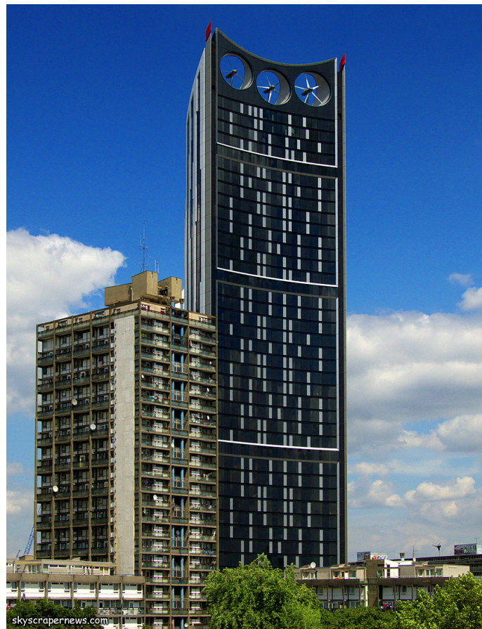
Рис. 6. Небоскреб Strata SE1, построенный в Лондоне. На венце здания установлены ветрогенераторы горизонтального типа
