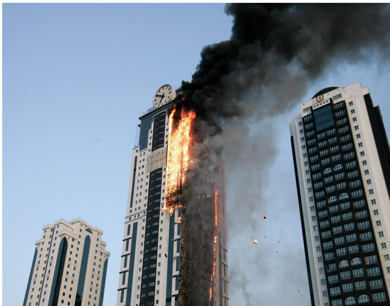
Рис. 9. Возгорание ветрозащитной пленки НВФ высотки «Грозный-сити» [16]
