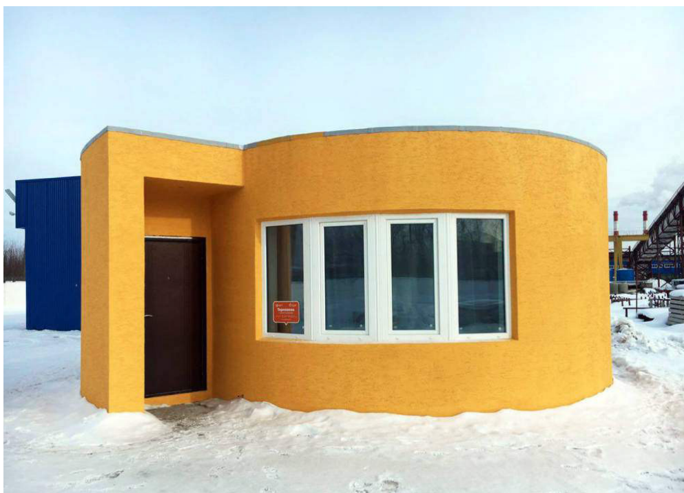
Рис. 15, 16. Процесс печати и готовый дом в подмосковном Ступино
