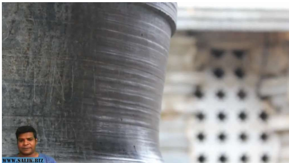
Рис. 22. Следы токарной обработки колон в храме Хосайлешвара [40]
