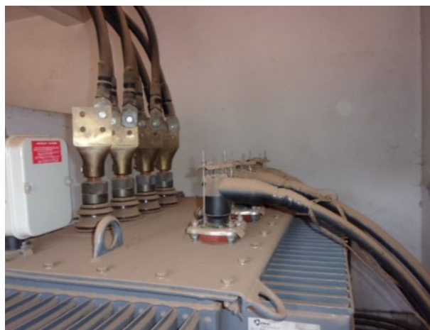
Рис. 4. Грязь в корпусе
