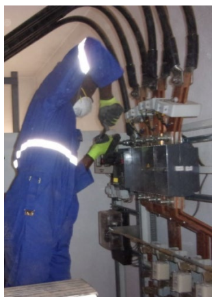
Рис.10. Затягивание гаек в РУ НН
