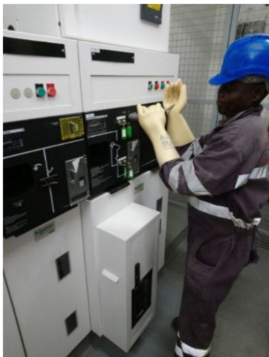
Рис. 14. Возврат ТП в рабочее состояние
