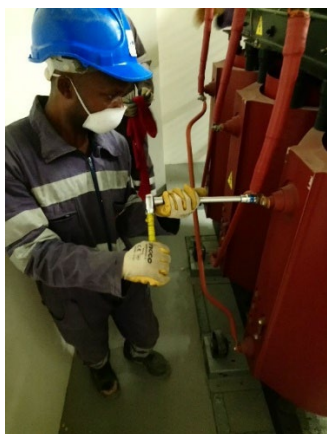
Рис. 9. Затягивание болтов в трансформаторе
