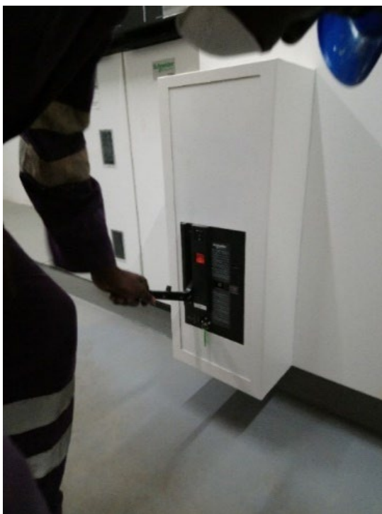
Рис. 14. Возврат ТП в рабочее состояние
