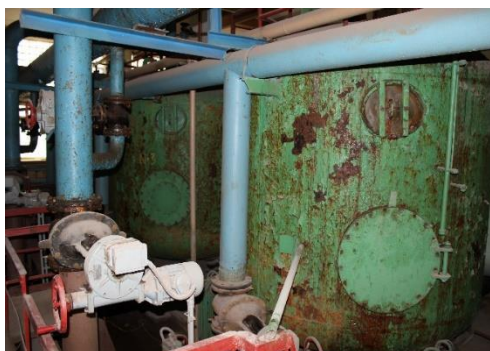
Рис. 1. Сооружения и технологические трубопроводы станции обезжелезивания, подверженные коррозии
