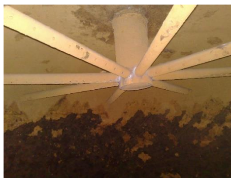
Рис. 1. Сооружения и технологические трубопроводы станции обезжелезивания, подверженные коррозии
