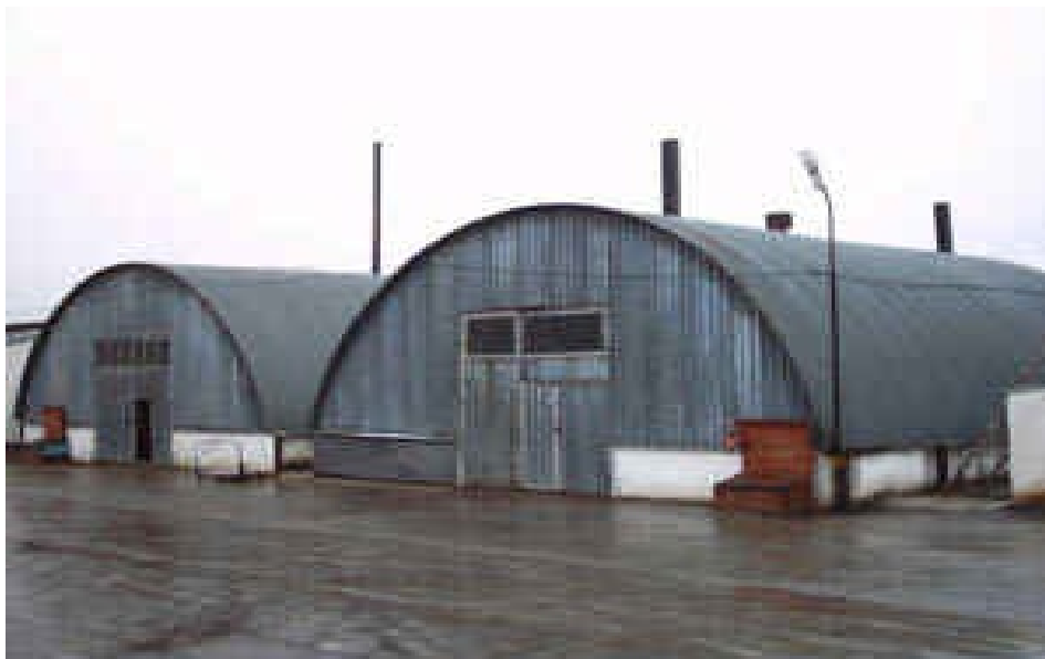
Рис. 6. Ангары для установки оборудования
