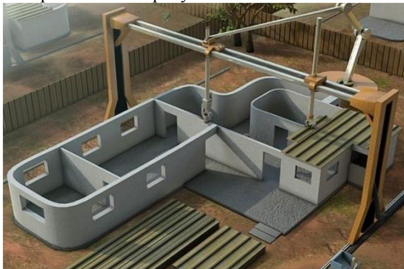
Рис. Принцип работы 3D принтера
