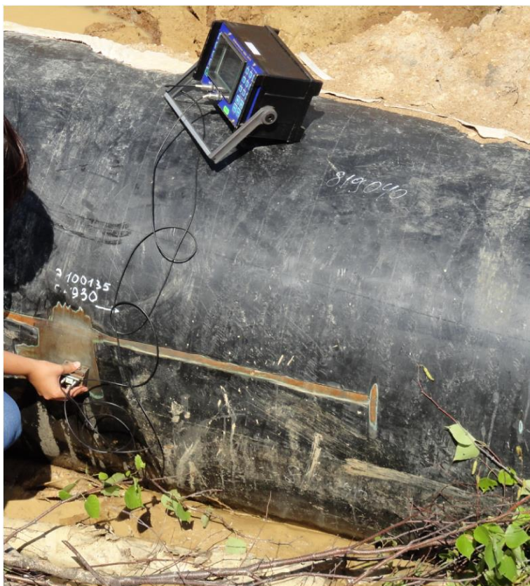
Рис. 4. Исследование риски на поверхности трубы электронной аппаратурой
