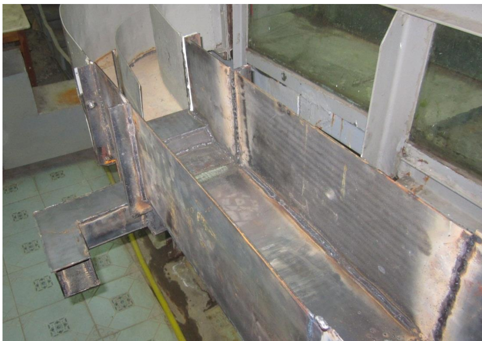
Рис. 6. Процесс установки водовыпуска-стабилизатора расхода воды из каналов с бурным режимом течения
