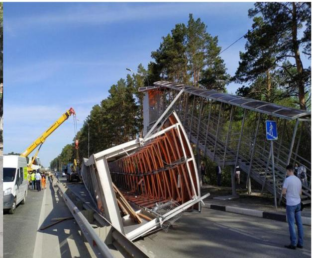
Рис. 2. Разрушение надземного пешеходного перехода в Мексике
