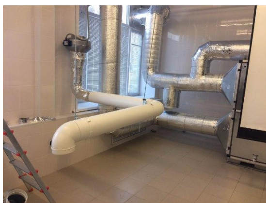
Рис. 3. Трубопроводы с одним изгибом: а) пластиковый; б) гибкий
