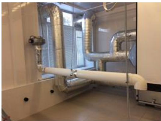
Рис. 2. Трубопроводы без изгибов: а) пластиковый; б) гибкий
