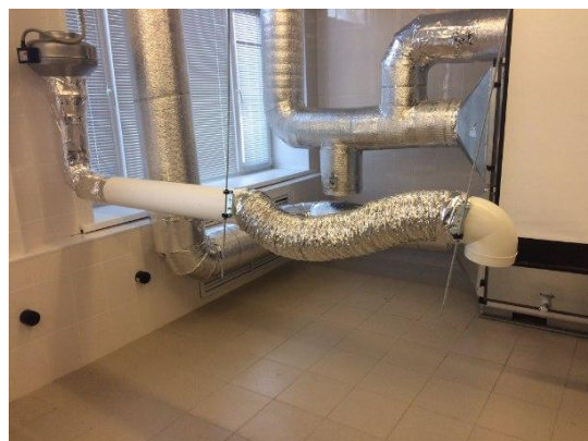
Рис. 2. Трубопроводы без изгибов: а) пластиковый; б) гибкий
