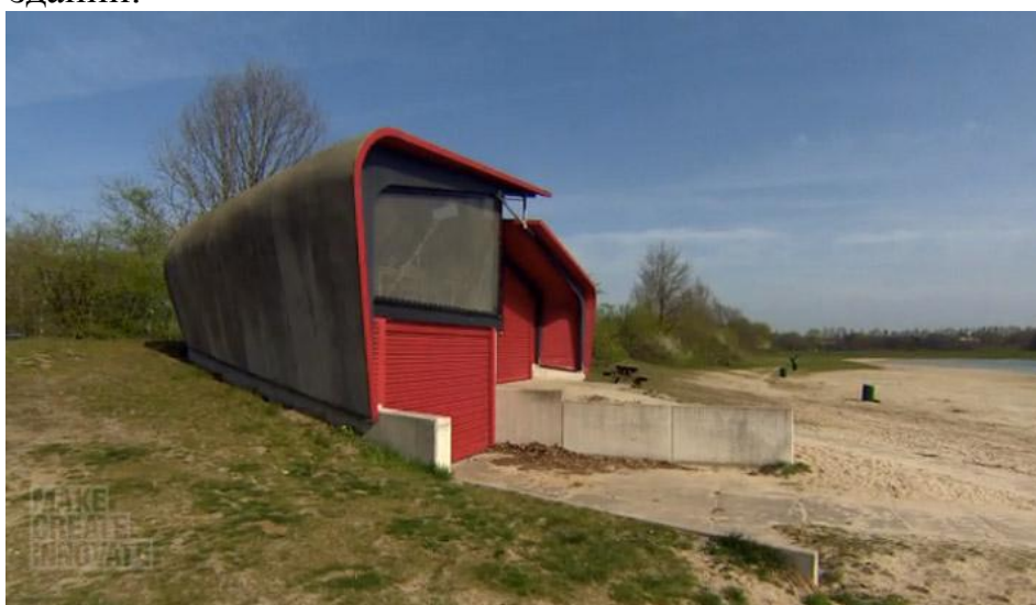
Рис. 2. Первый прототип, построенный с использованием самовосстанавливающего бетона
