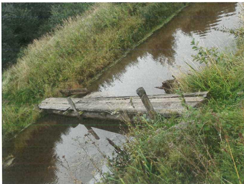
Рис. 6. Участок канала ПК20+40
