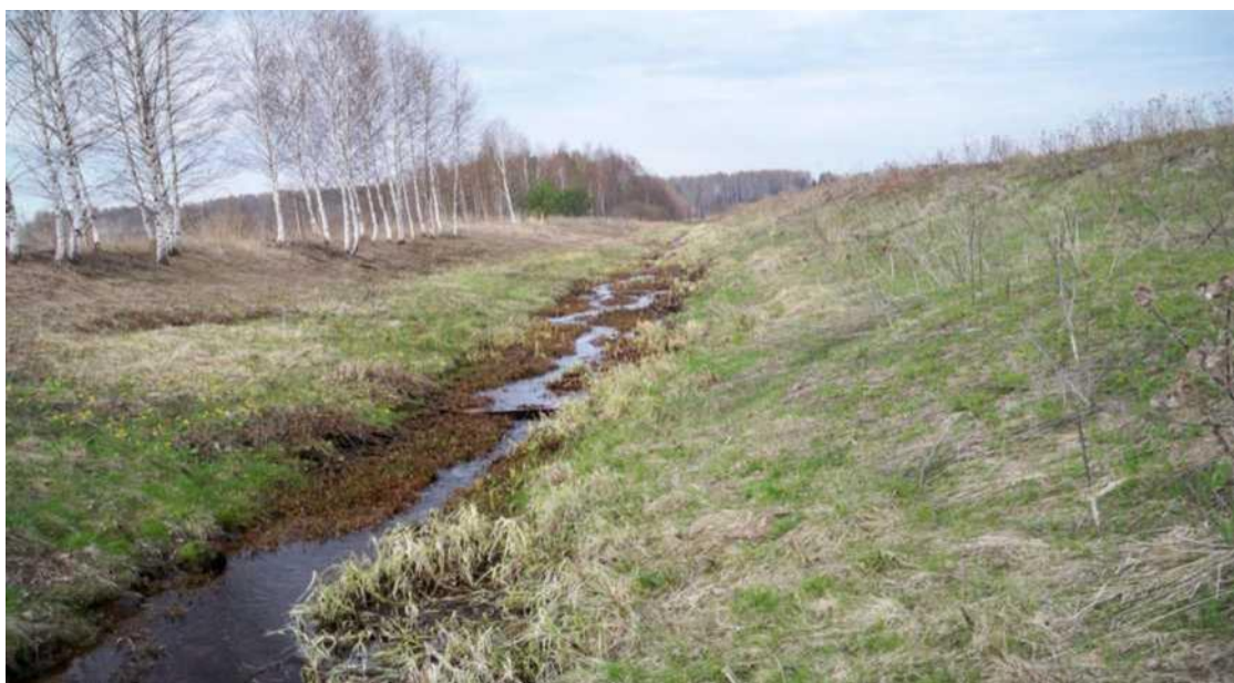
Рис. 4. Магистральный канал на ПК14+00
